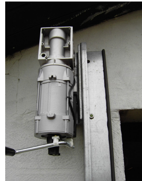
Gearmotor med indbygget bremse.
